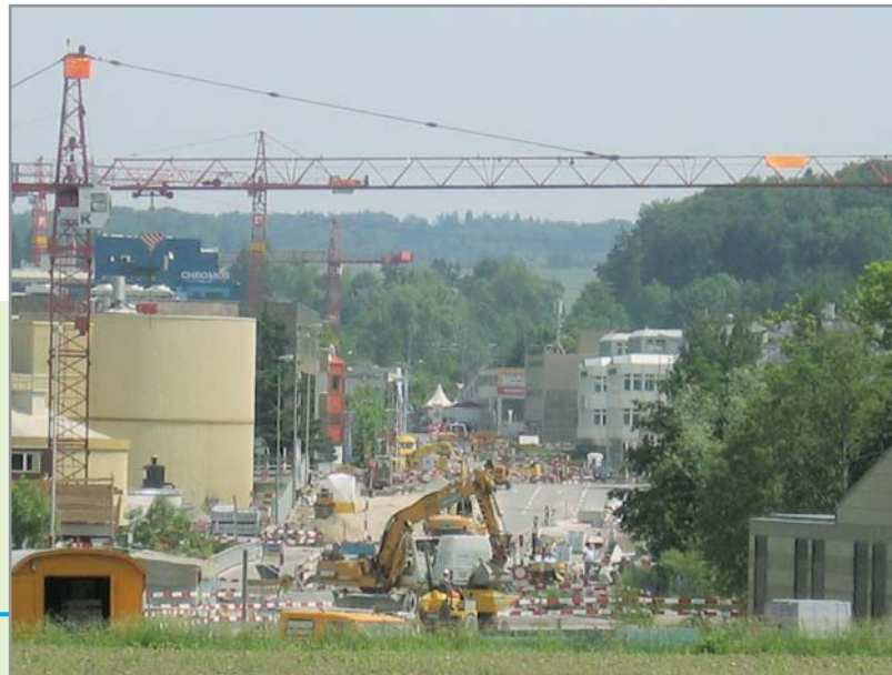
Bauarbeiten im Bereich der Flughafenstrasse.
