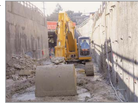
Baugrube des Stelzentunnels.
