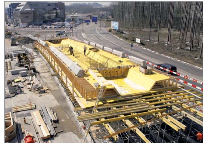
Bauarbeiten am Viadukt Balsberg.
